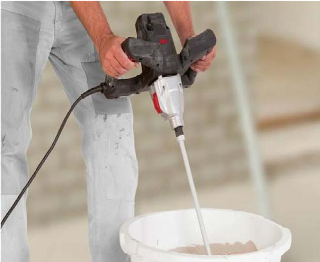
Отмерять необходимое количество воды затворения исходя из расчета 0,17-0,2 л воды на 1 кг сухой смеси. При перемешивании сухую смесь постепенно добавлять в воду. Перемешать в течение 1-2 минуты до получения однородной консистенции. Выдержать паузу в течение 1 минуты. При необходимости добавить воду и вновь перемешать. Воду добавлять в количестве не превышающем максимального. Использовать за 60 минут.
